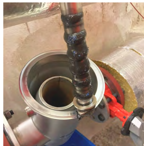
Servis filtru RD2.3 – magnet a filtrační vložka
