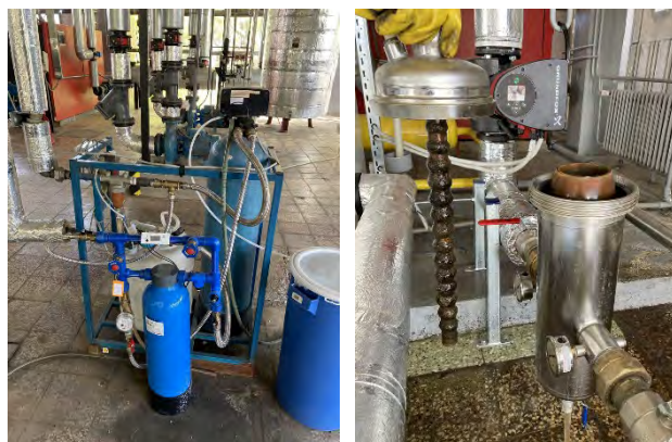
Servis a údržba demineralizačních jednotek a nerezových magnetických mechanických filtrů v Brně
