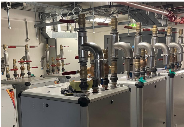
Ukázky instalací s tepelnými čerpadly
